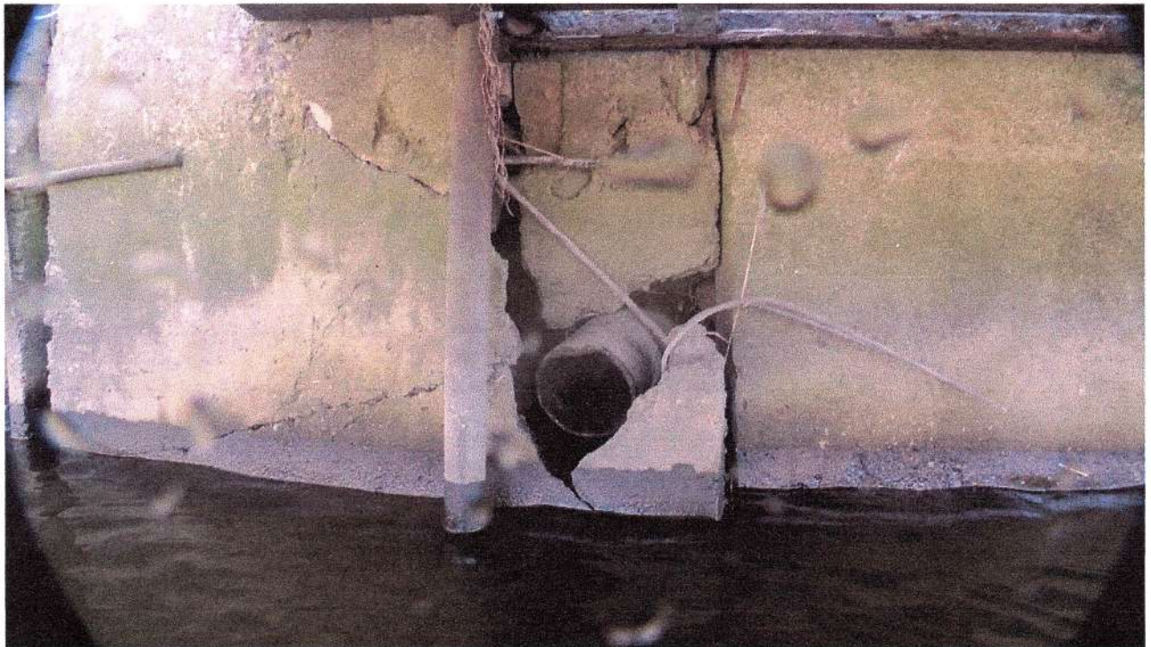
Toliau ~ 10 m atkarpoje ištrupėjęs betonas, išplauta krantinė.
